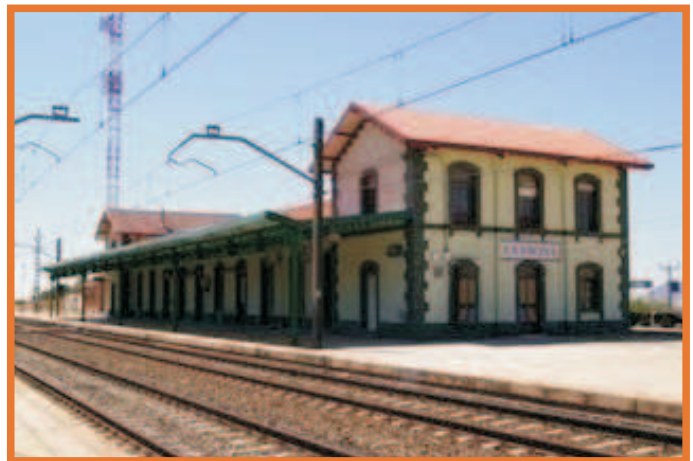
Estación ferroviaria de La Encina (Villena -Alicante)
